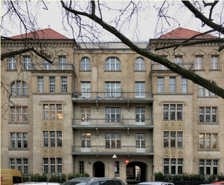
Sanierte Straßenfassade (Quelle: www.ernst-architekten.de )
