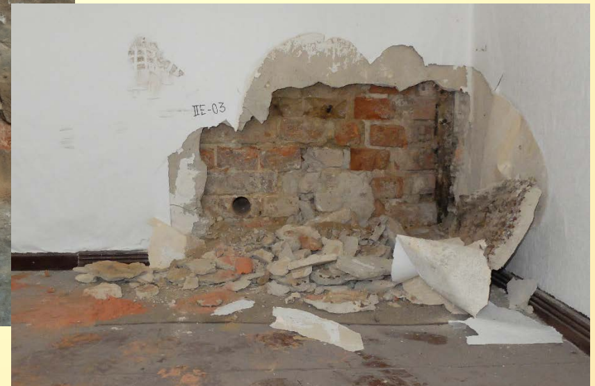
Mauerwerk (außen und innen)
