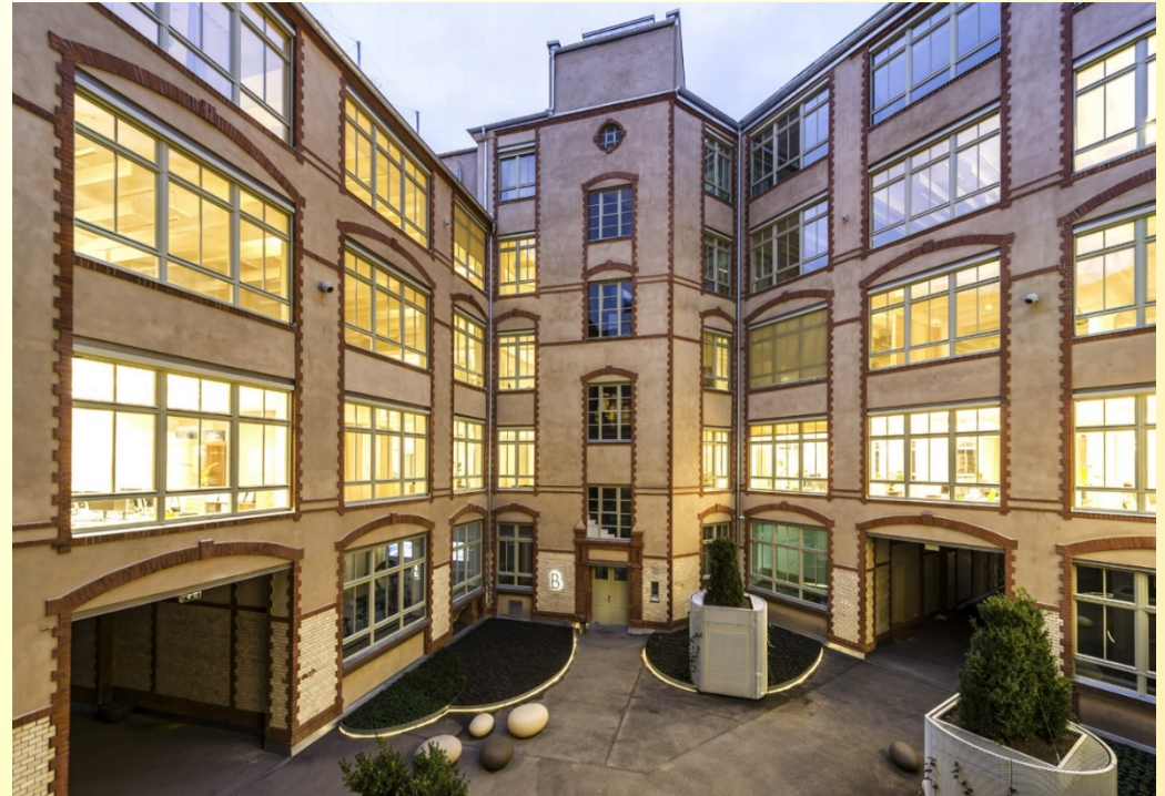
Sanierter Innenhof (Quelle: www.ernst-architekten.de )
