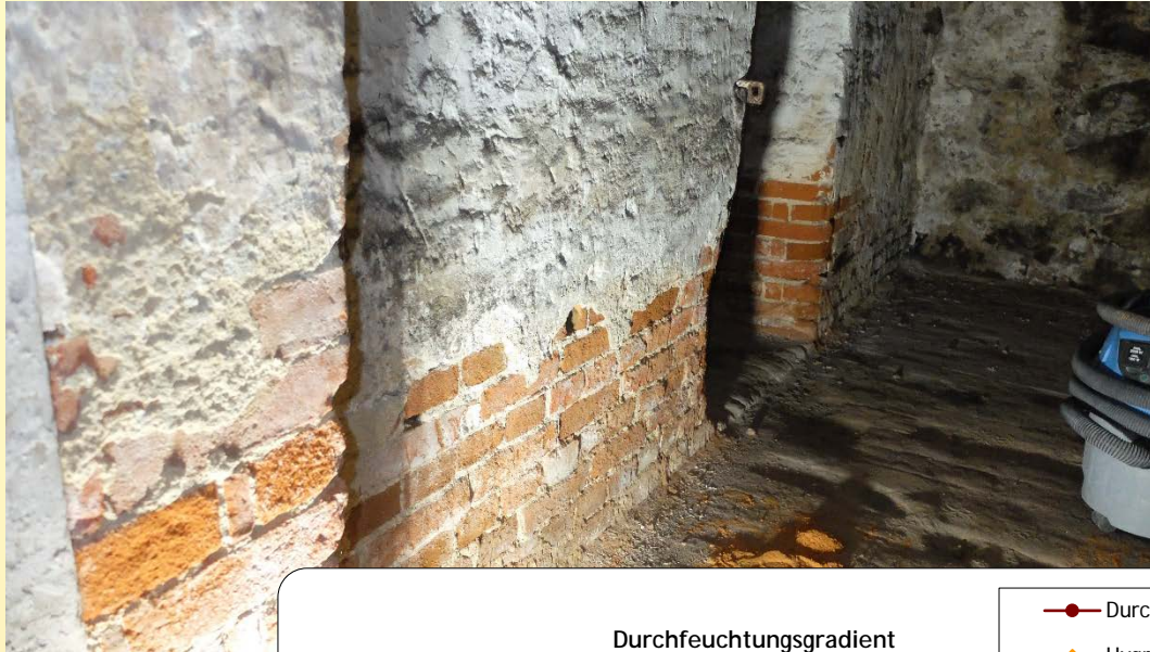
Typisches Schadbild der Kellerinnenwände
