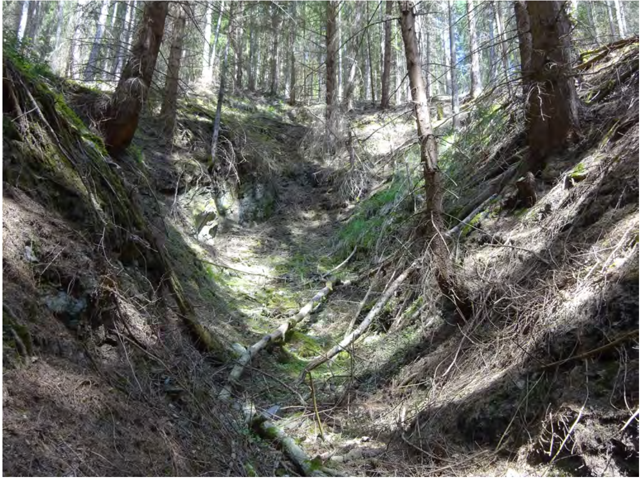
Bild 59 Verschüttetes Stollenmundloch im unteren Kirchberg (Foto: Jonny Henkel)
