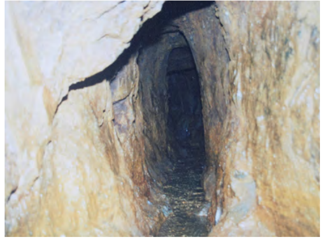
Bild 70 Gesäuberter Entwässerungsstollen auf Breitenbacher Seite (Foto: Hartmut Winkler, zur Verfügung gestellt von Bernd Krannich)
