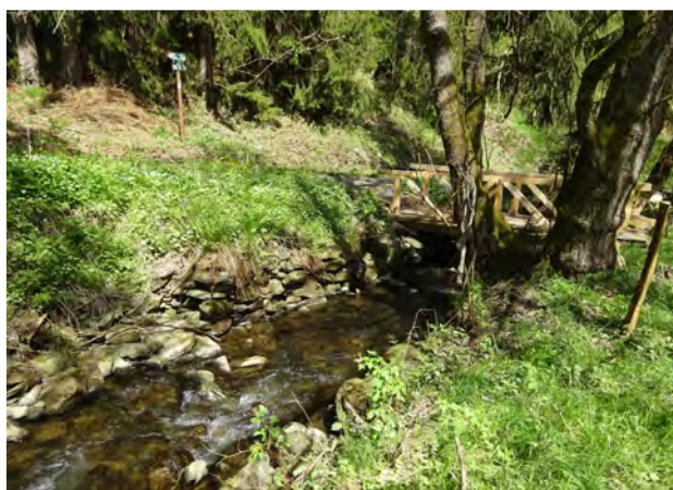
Bild 50 Mit Trockenmauern befestigtes Bachufer (Foto: Jonny Henkel)
