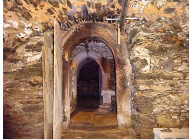
Bild 31 Rundbogengewände und nachträglich eingebaute Spitzbogengewände am Kellerzugang des Hauses Dorfstraße 25
