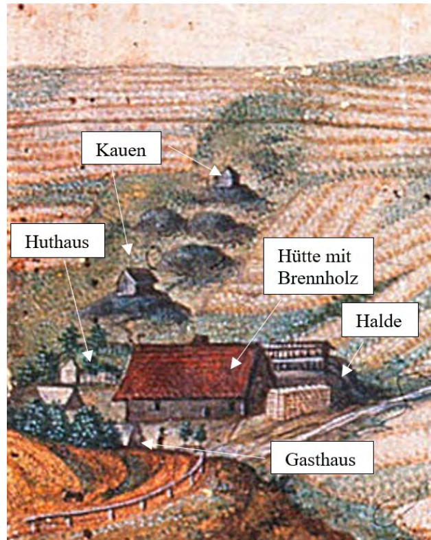
Bild 67 Bergwerksgebäude oberhalb der Wallbrücke um 1820 (siehe Titelbild)
